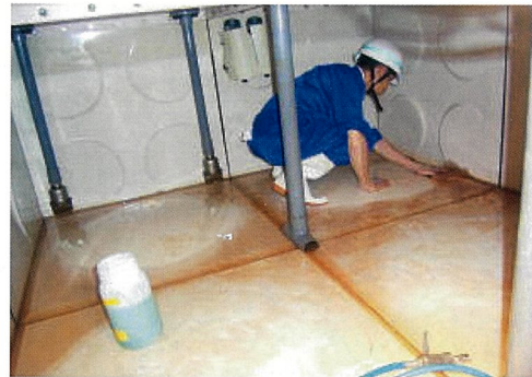
貯水槽内清掃の様子
