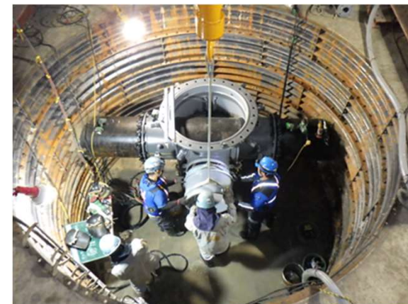
<犀川配水池耐震補強工事(耐震壁設置)>
