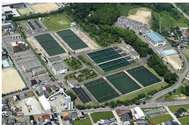
末浄水場(全景)
