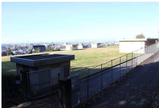
四十万中配水場(上部)
