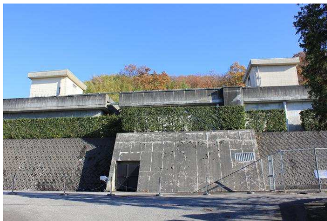
四十万中配水場(下部)
