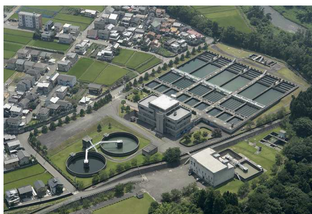
犀川浄水場(全景)
