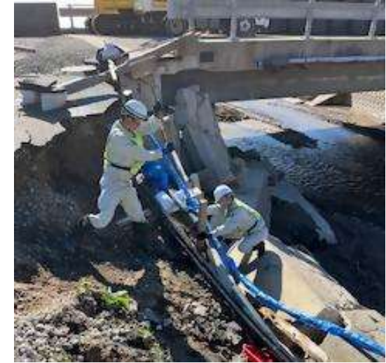
応急復旧 (水道)
