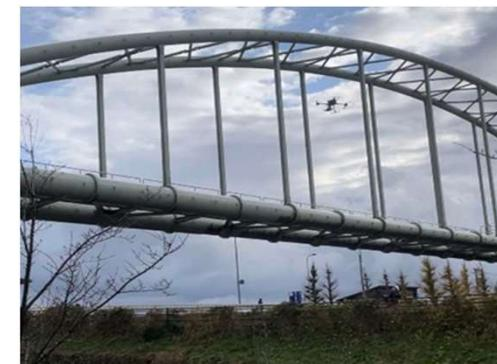
ドローンによる水管橋点検
