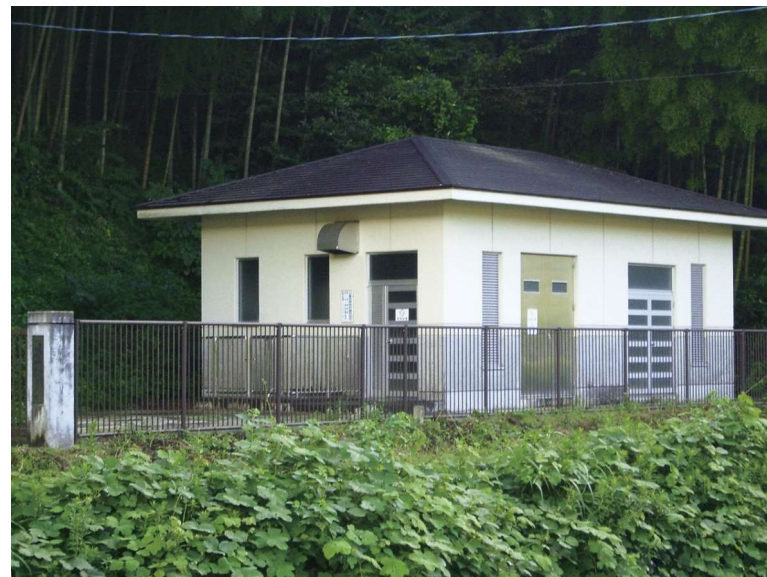
下涌波導水ポンプ場
