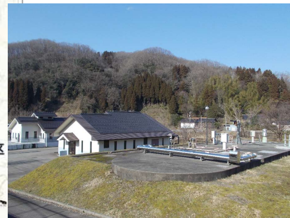
湯涌水質管理ステーション (湯涌処理区)
