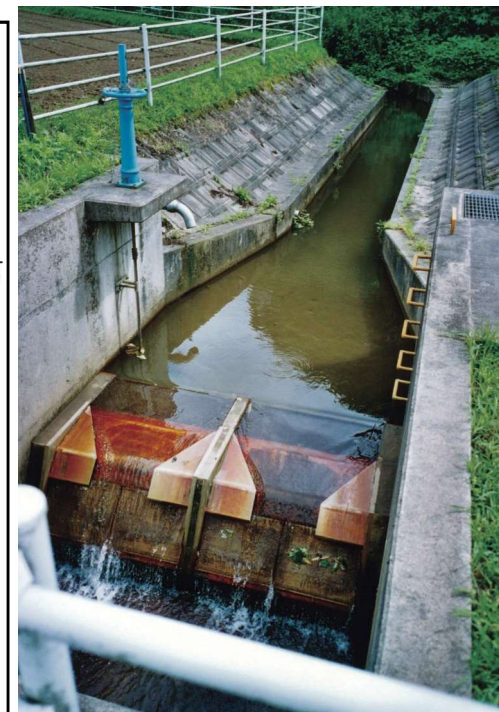
涌波川支川取水施設
