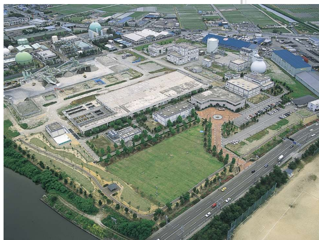
臨海水質管理センター (臨海処理区)
