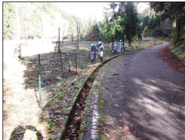
動物侵入柵の設置
