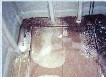
水槽底部に錆が沈殿している。
