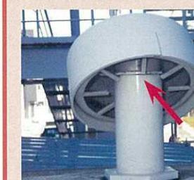
通気管の破損・防虫網の破れ。
