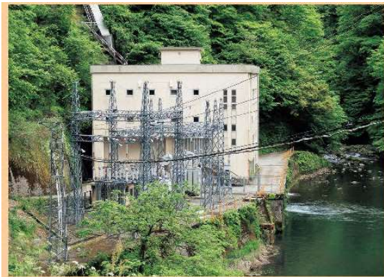
上寺津発電所
