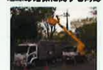
災害時の停電復旧作業
