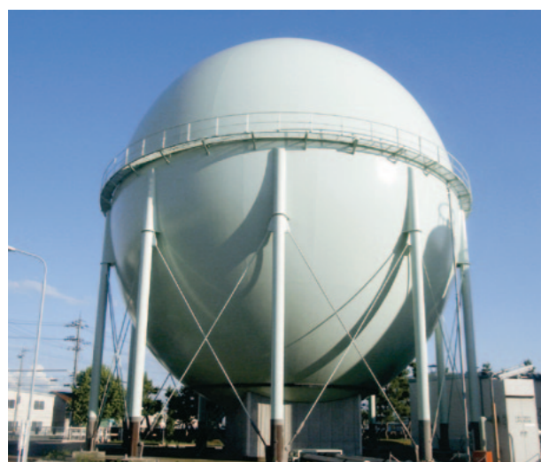
耐震化済の球形ホルダー (港エネルギーセンター)
