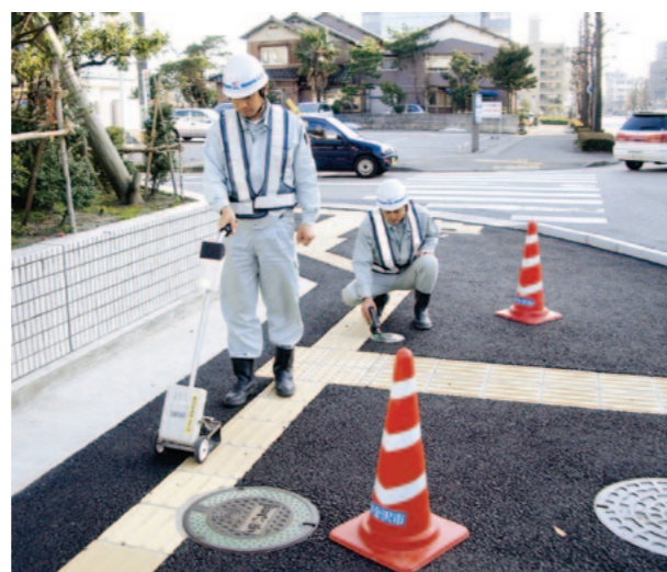
ガス保安対策 (路上でのガス漏れ調査)
