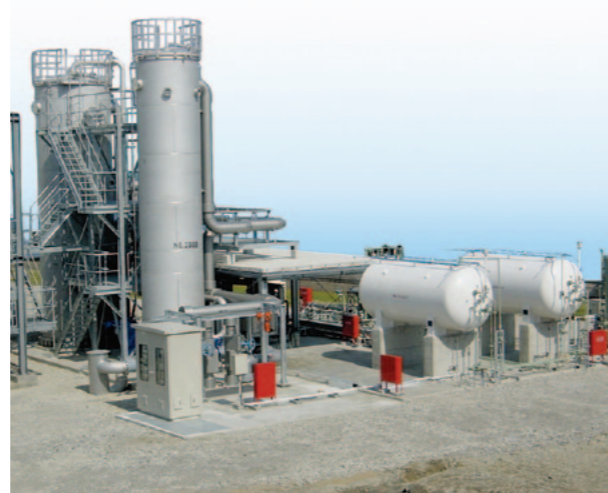
精製消化ガス供給設備 (臨海水質管理センター)
