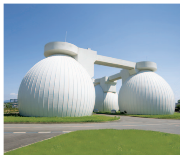
汚泥消化タンク (城北水質管理センター)
