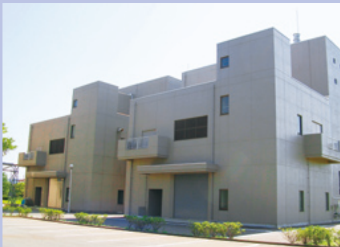
▼汚泥共同処理施設
