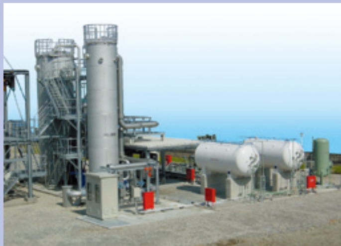
▼精製消化ガス供給設備(臨海水質管理センター)
