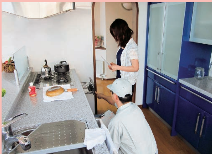
▼ガス漏れ調査
