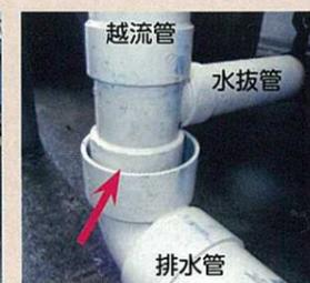
越流管 水抜管 排水口空間がない。
