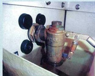
ボールタップ弁の不良で吐水口が水没している。
