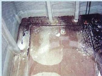
水槽底部に錆が沈澱している。
