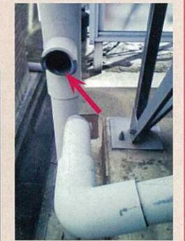
越流管の破損。
