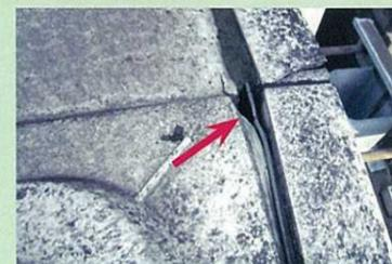
貯水槽本体が変形し、隙間がある。
